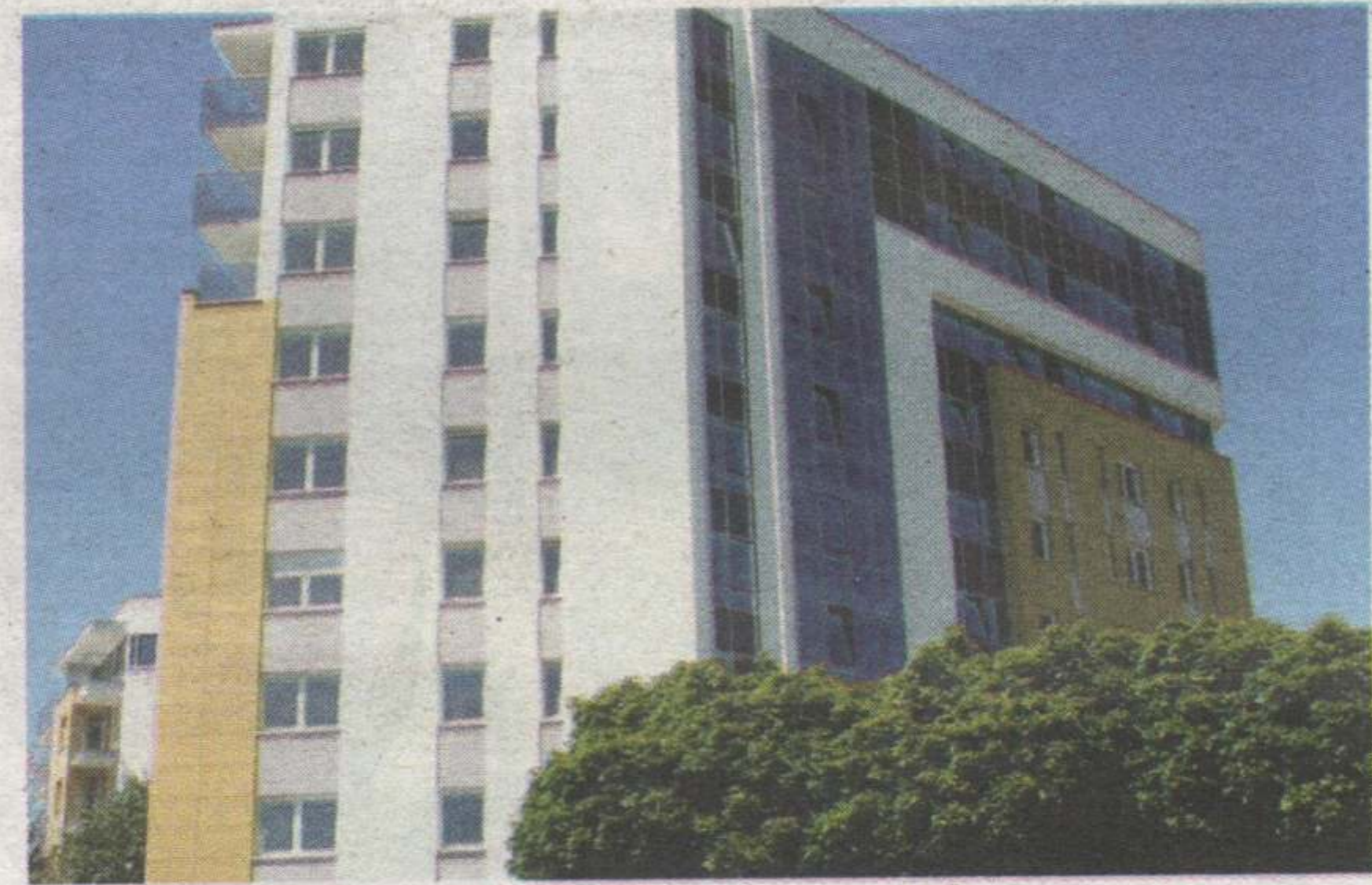
W rejonie ulic Marcelińskiej, Wałbrzyskiej i Świerzawskiej firma Ataner buduje nowoczesny Zespół Mieszkaniowy Marcelin
