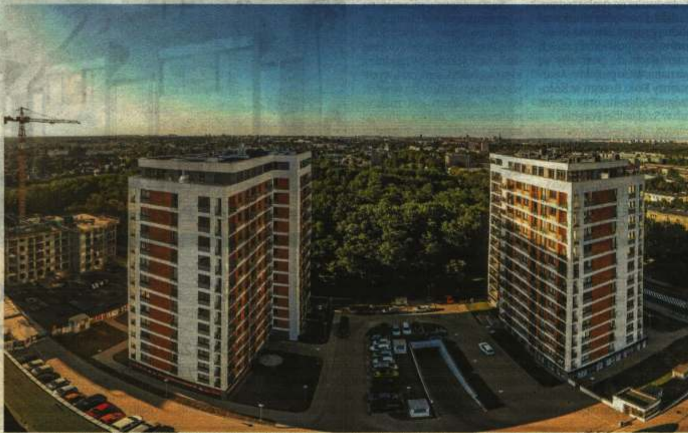
Docelowo Red Park będzie się składał z czterech 14-kondygnacyjnych budynków. Trwa budowa trzeciego
