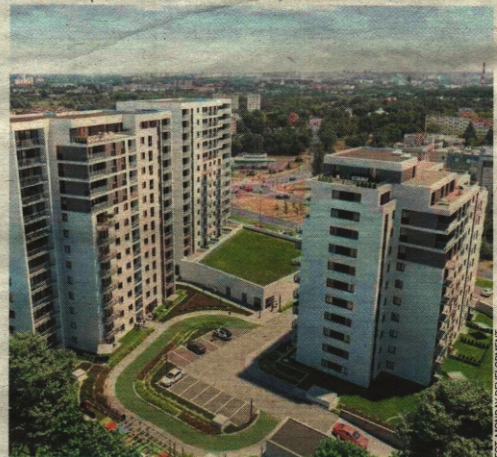
Mieszkania na osiedlu Nowych Kosmonautów zostaną oddane do użytku już za pół roku
