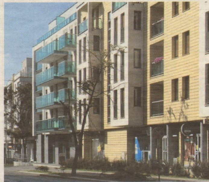
► Kamienica u zbiegu ulic Szanieckiej i Kasprzaka harmonijnie wpisana się w okoliczną zabudowę
