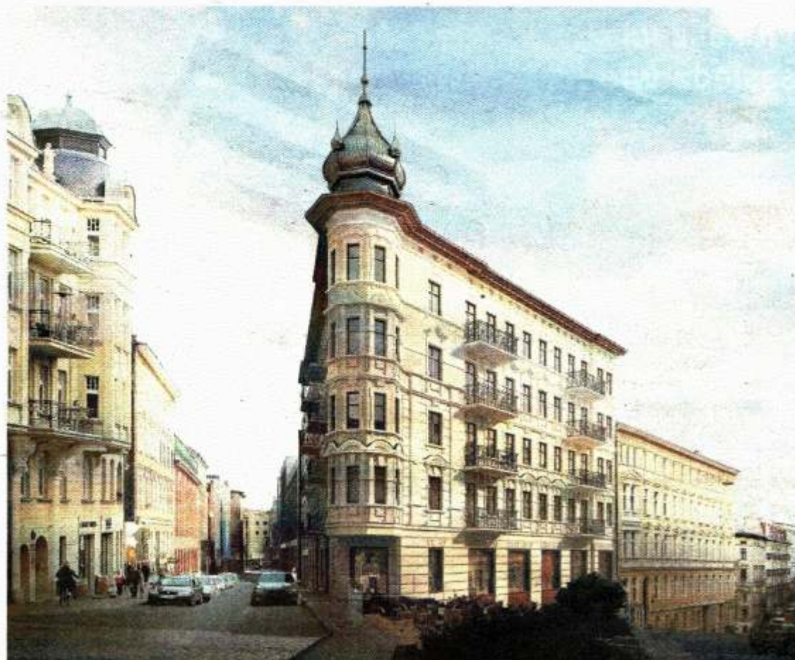
Kamienica „żelazko” to jeden z najbardziej rozpoznawalnych poznańskich budynków
