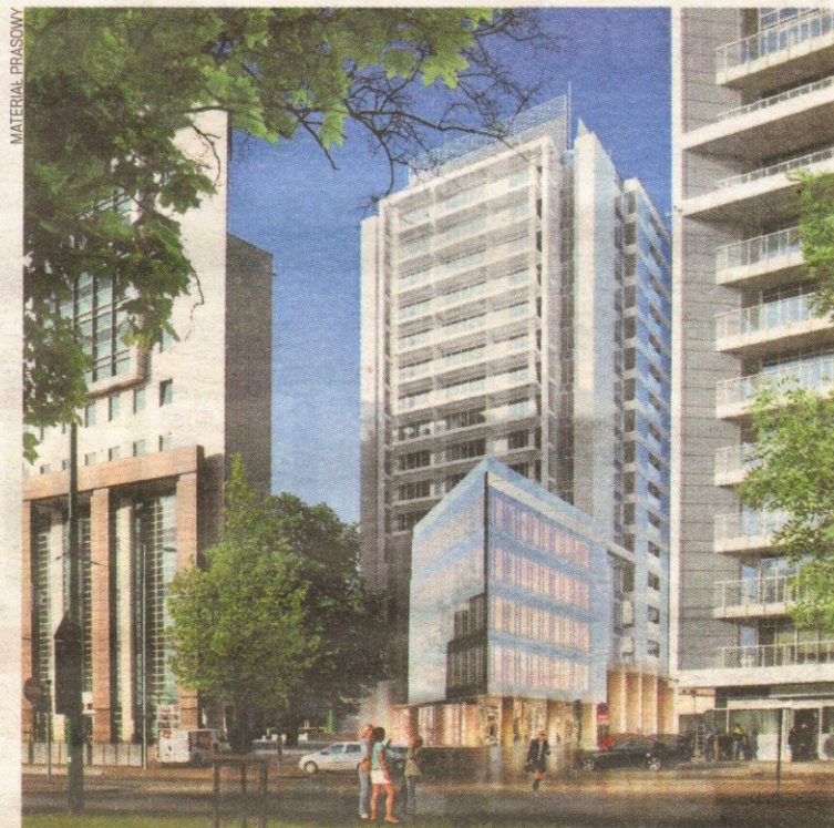
Budowany przez Ataner wieżowiec przy ul. Towarowej 37 ma 16 pięter
