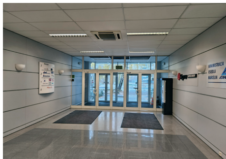
Zdjęcia hallu przed renowacją.
