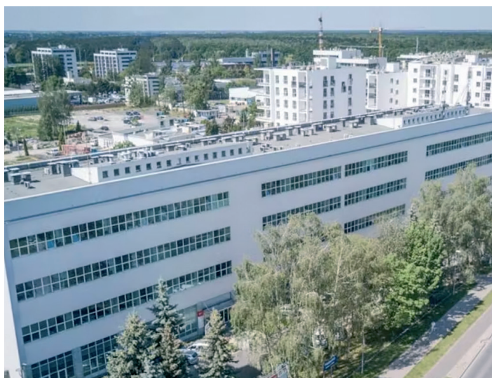
Fasada budynku przed renowacją.
