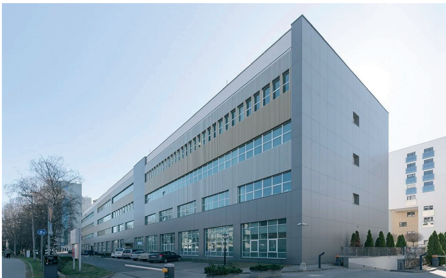
Fasada budynku po renowacji.
