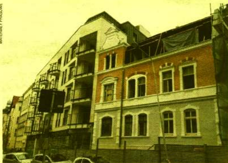
Budowa osiedla Różana na Wildzie
